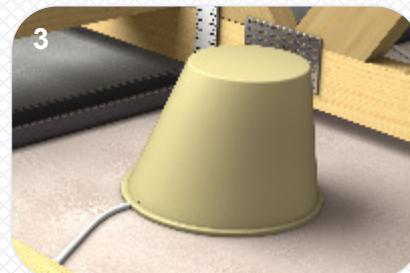
4. Souffler l'isolation sur le Capot de Spot jusqu'à ce que la profondeur requise soit atteinte.
